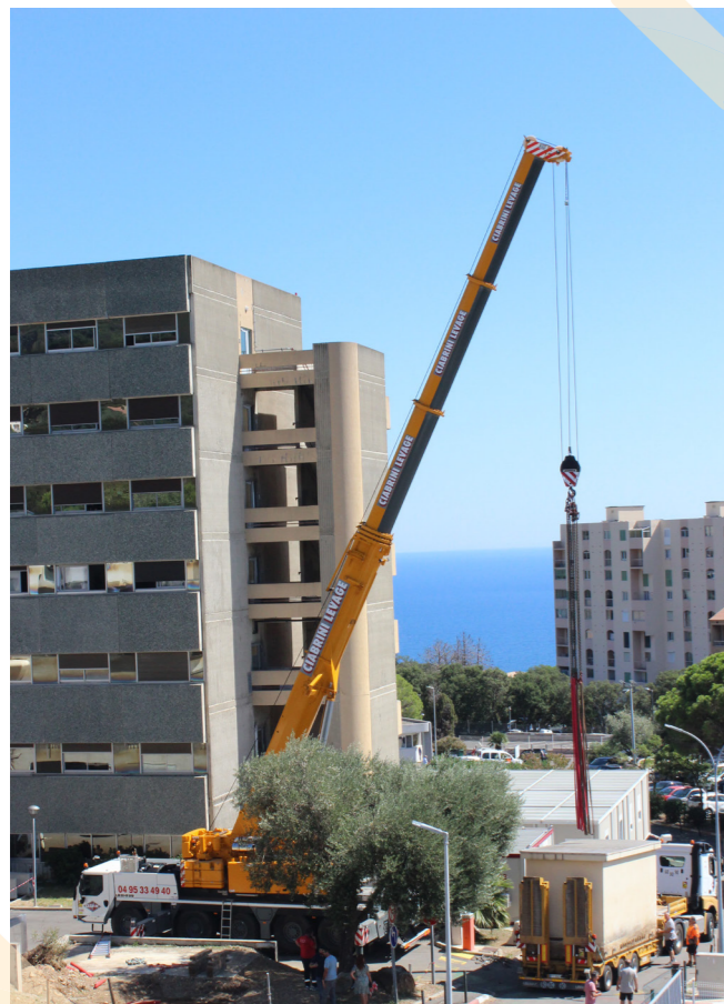
Travaux - Création des locaux PMA
